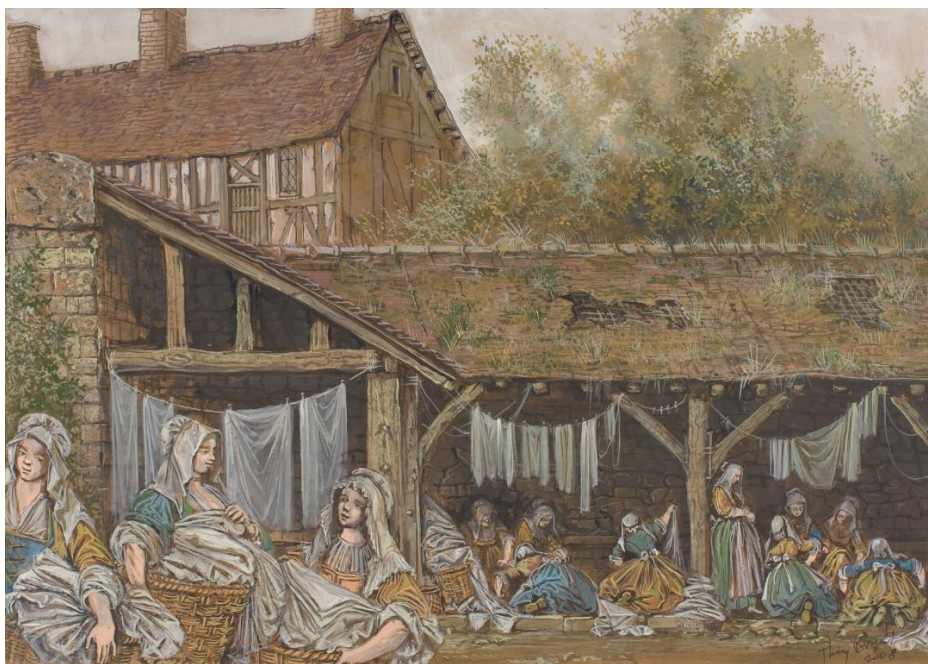
Lavoir de Rennemoulin
