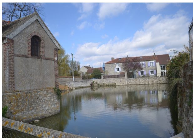
Figure n°6 : Photographie d'une mare artificielle à Montainville
