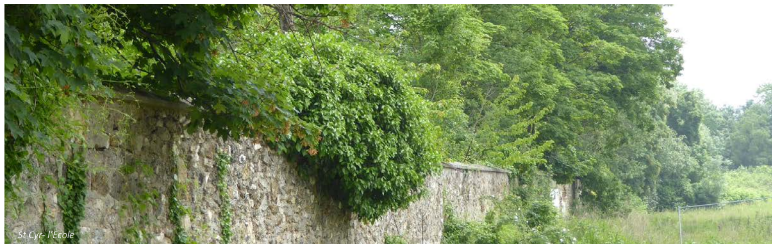
Mur démontrant les nécessaires règles d'entretien du mur et d'implantation du végétal pour la bonne conservation du mur (nettoyage annuel).
