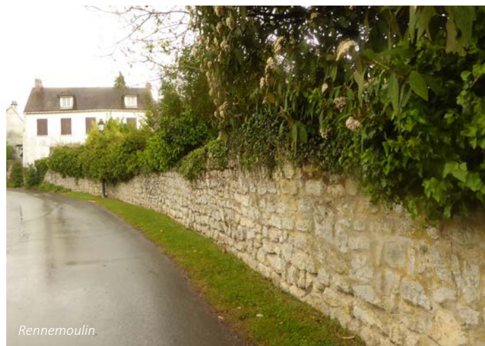
Joint en retrait de la pierre saillante. Mur en pierres privé, face à la Plaine.
