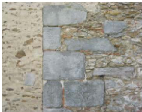
Moellons calcaire : pierre calcaire utilisée pour la construction, un peu taillée
