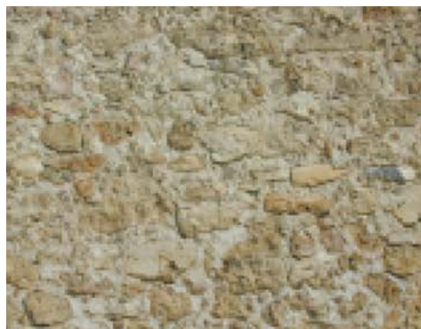
Moellons calcaire : pierre calcaire utilisée pour la construction, un peu taillée
