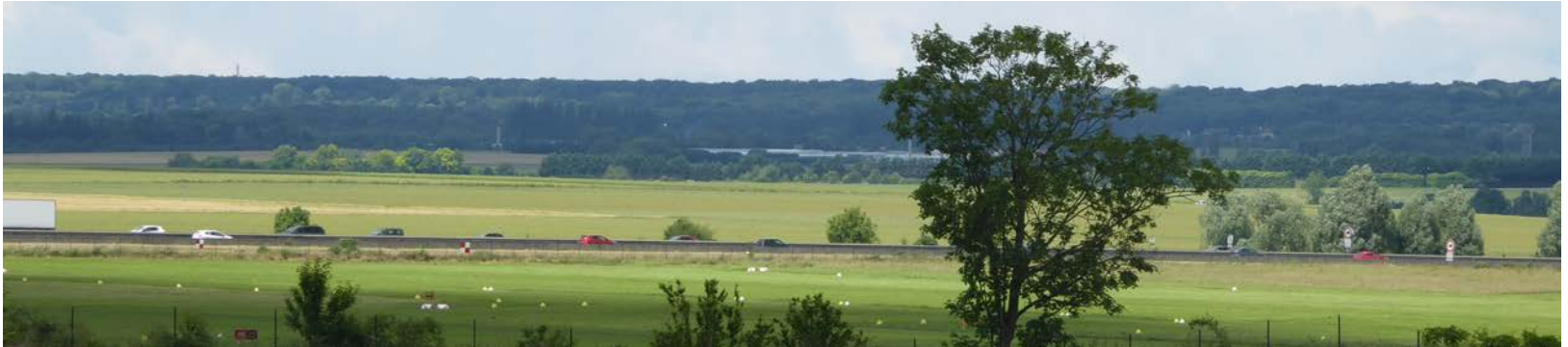
Autoroute A12 ne masquant pas la Plaine par de longs alignements arborés ou arbustifs
