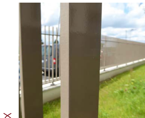
Section plate du barreaudage
