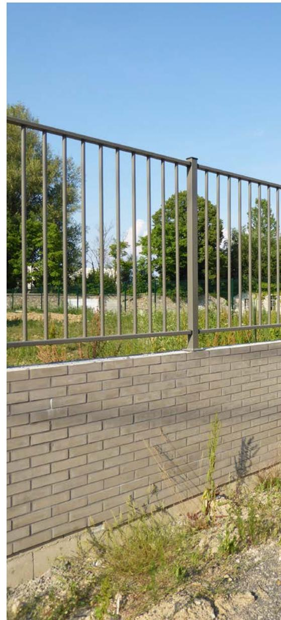
Mur-bahut surmonté d'une clôture métal à barreaudage de section ronde, couleur brun foncé RAL 7039 St Cyr-l'Ecole
